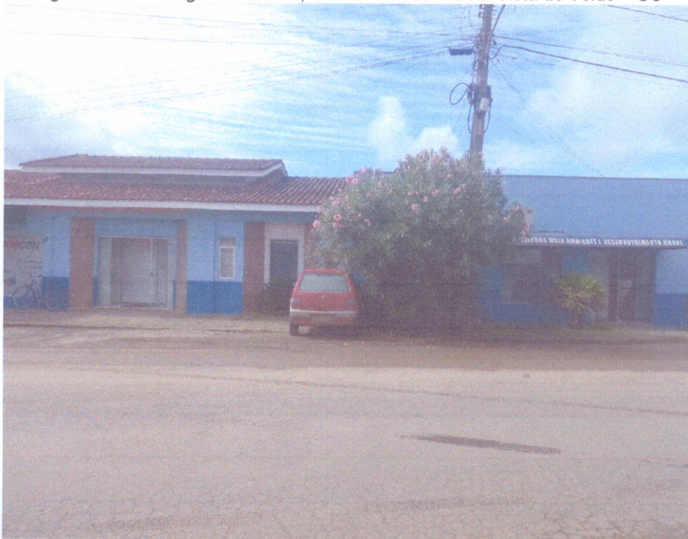
Imagem 09: Rua Augusto Kuchler, nº 39 – Centro – Bela Vista do Toldo – SC
